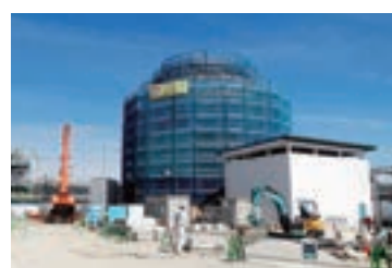
液化水素荷役実証ターミナル 2500m 3 球形 液化水素貯蔵タンク洗浄 写真提供： 川崎重工業株式会社
