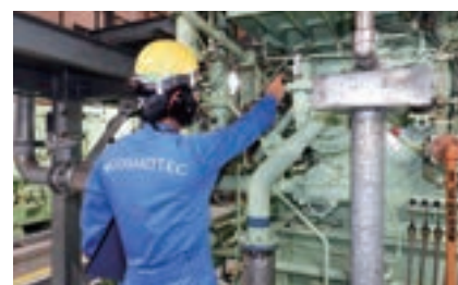
発電機点検（種子島宇宙センター）
