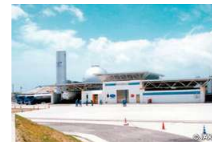
高圧ガス貯蔵供給所
