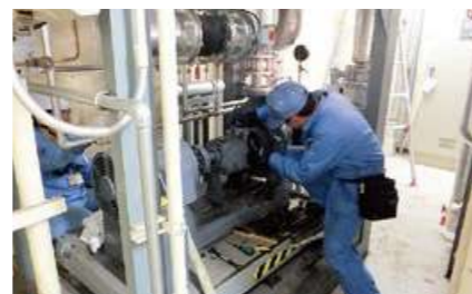
空調点検作業（筑波宇宙センター）
