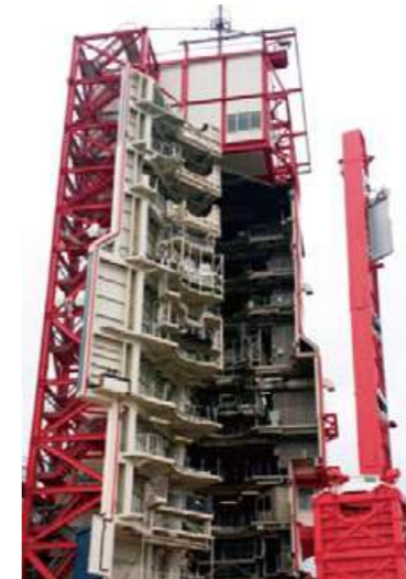
イプシロンロケット整備棟改修工事
